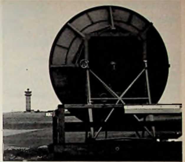
Blik vanaf de zendtoren op de ontvangpost, een houten toren van 26,5 m hoogte, met draaibare paraboolspiegel. (foto SEL)
